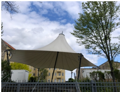
Bild 1: Blick auf den Kulturbunker von der Rungiusstraße (MTS, 26.04.23)
